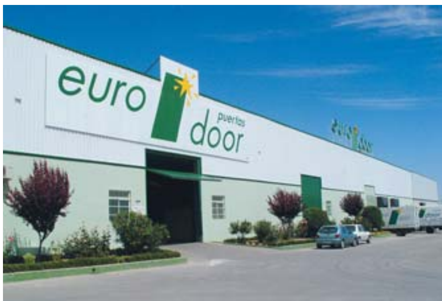
Fachada de Eurodoor, en Tembleque (Toledo)
